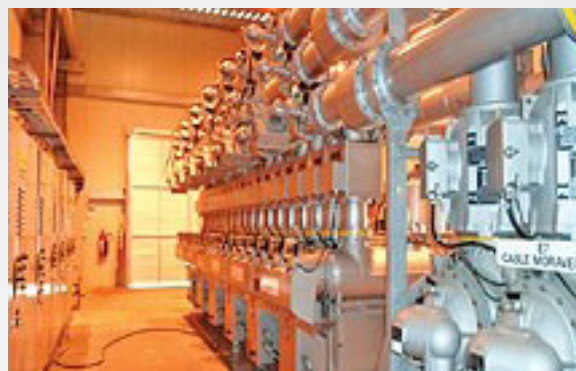
Fig. 2. Subestación encapsulada
