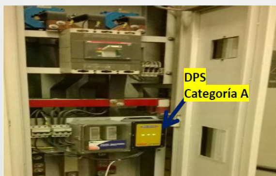
Fig. 5. Interruptor de la Subestación en BT, Categoría C
