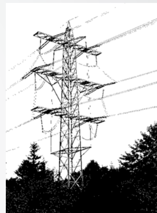
Fig. 3. Torre de transposición.
