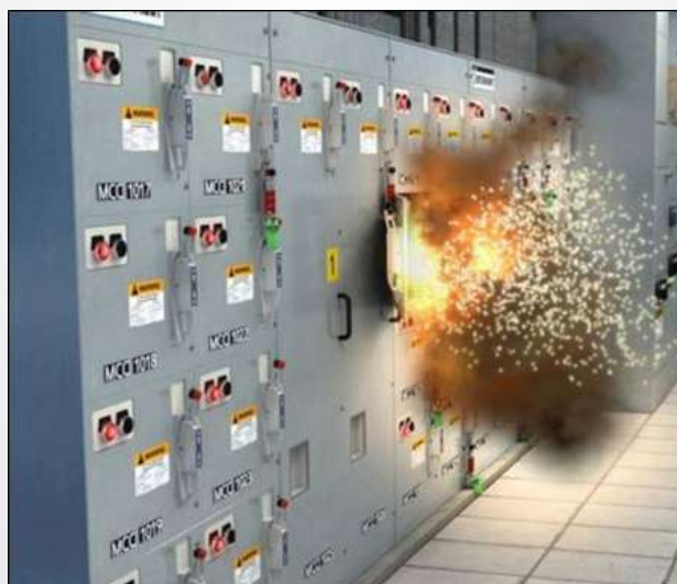
Fig. 4. Efecto del arco eléctrico en las subestaciones.
