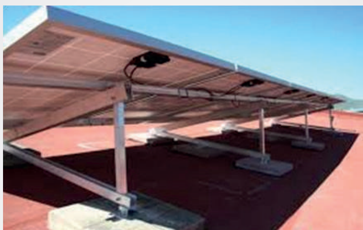
Fig. 8. Efecto sombra que ocasiona la soporteria o strings, y evita el reflejo de albedo.
