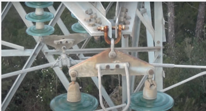
Fig. 5. Inspección visual de componentes de la estructura de alta tensión.
