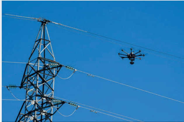
Fig. 4. Inspección de drone.
