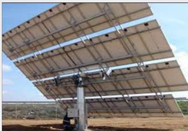
Fig. 7. Sistema de transmisión de seguidor solar.
