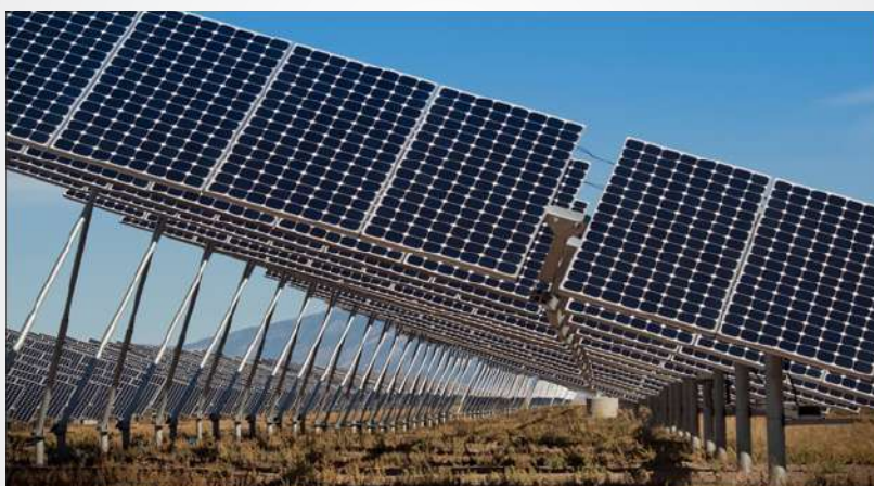
Fig. 1. Sistema de seguimiento solar de dos ejes.
