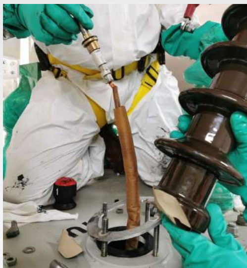
Fig. 4. Reemplazo de bushing dañado
