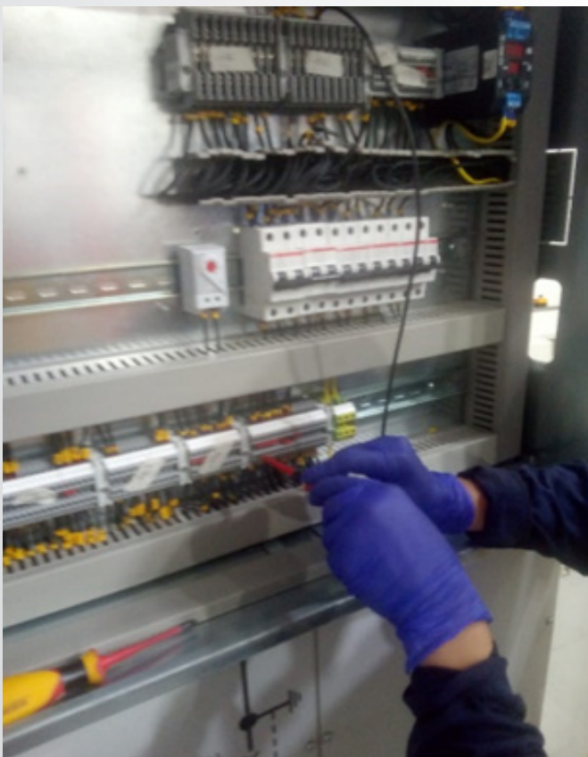
AJUSTE DE CABLEADO DE CONTROL
