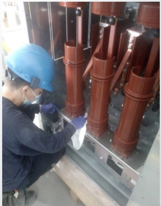
LIMPIEZA Y REVISIÓN DE COMPONENTES INTERNOS (INTERRUPTOR)
