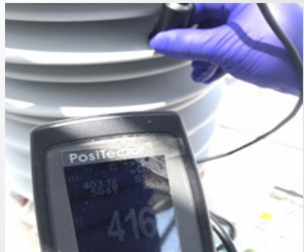
MEDICIÓN DE ESPESOR DE RECUBRIMIENTO EN TRANSFORMADOR DE TENSIÓN.
