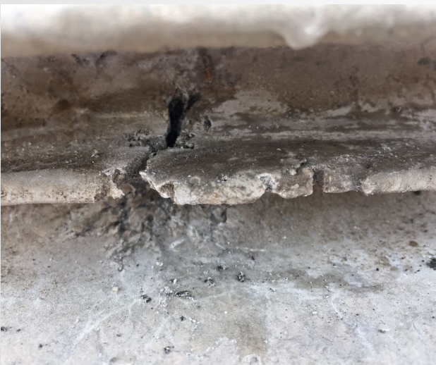
GRIETAS Y ROTURAS PRESENTES EN TERMINALES DE CABLE.
