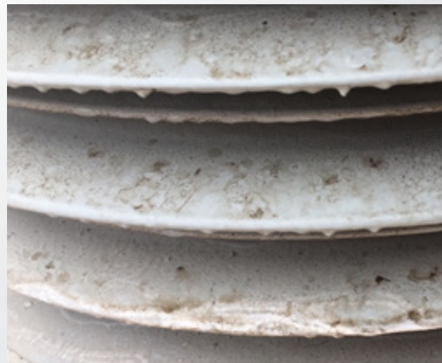
GOTEO DE SILICONA PRESENTE DE APLICACIÓN ANTERIOR.
