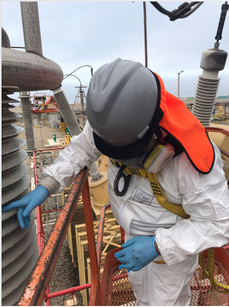
EQUIPOS RESANADOS CON SILICONA CSL DE CURADO NEUTRA.
