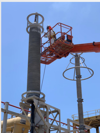
APLICACIÓN DE SILICONA RTV
