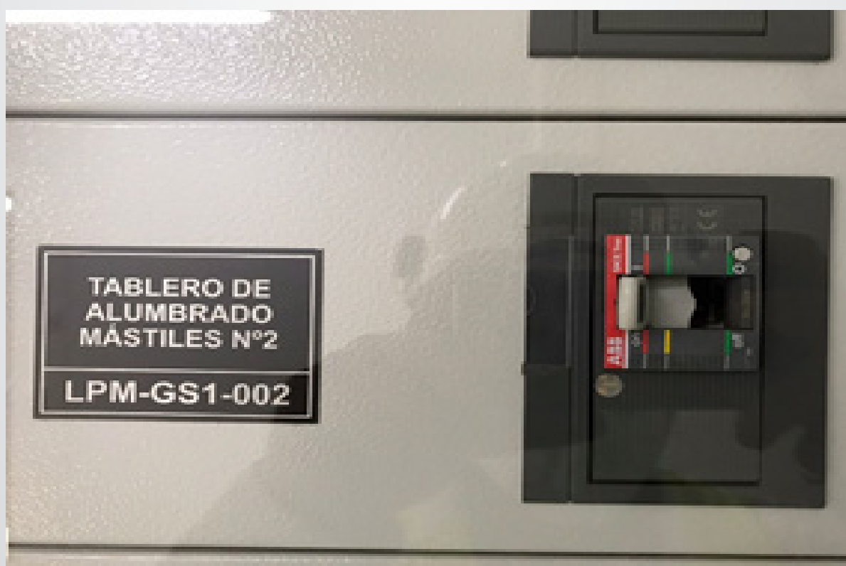
PALANCA DE INTERRUPTOR DAÑADA
