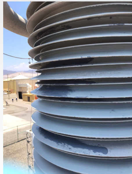
REMOCIÓN DE SILICONA ANTERIOR MAL ADHERIDA EN EL EQUIPO POLIMÉRICO.
