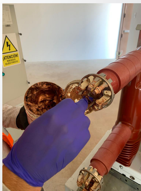
REAPLICACIÓN DE GRASA CONDUCTIVA EN CONTACTOS DE INTERRUPTOR.
