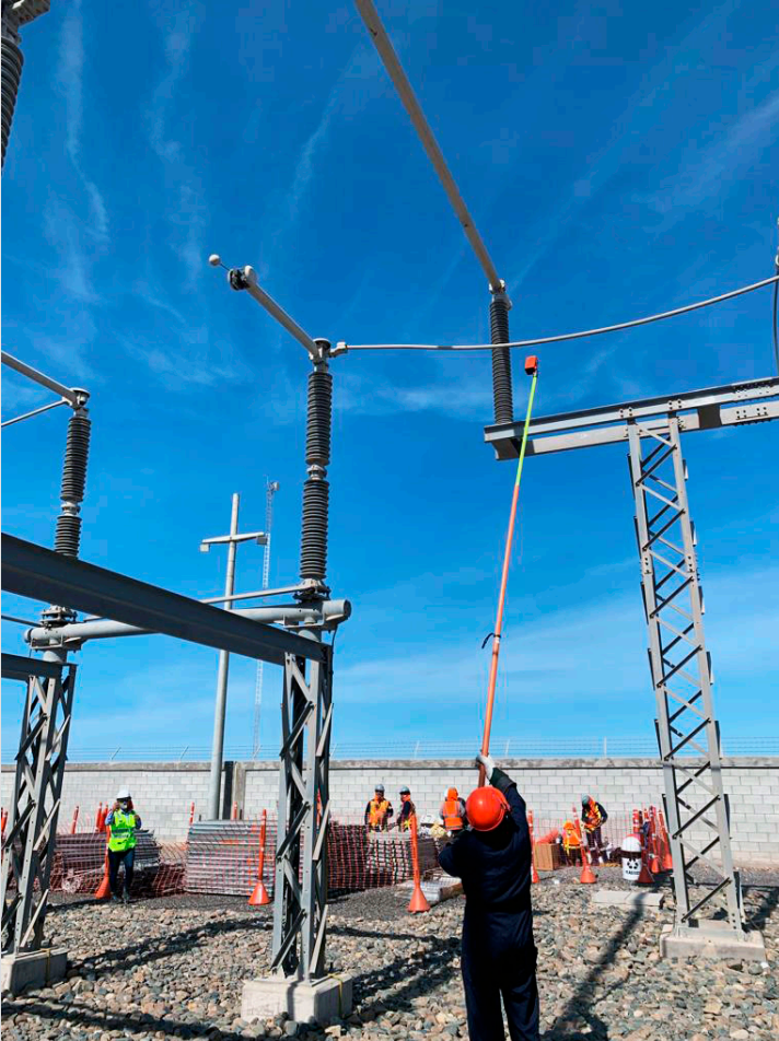
VERIFICACIÓN DE AUSENCIA DE TENSIÓN EN LÍNEA A INTERVENIR
