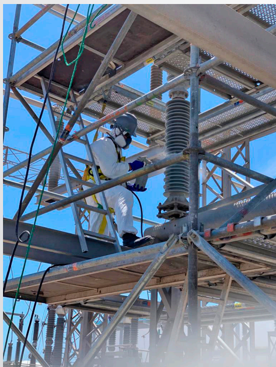
APLICACIÓN DE SILICONA A SECCIONADOR.
