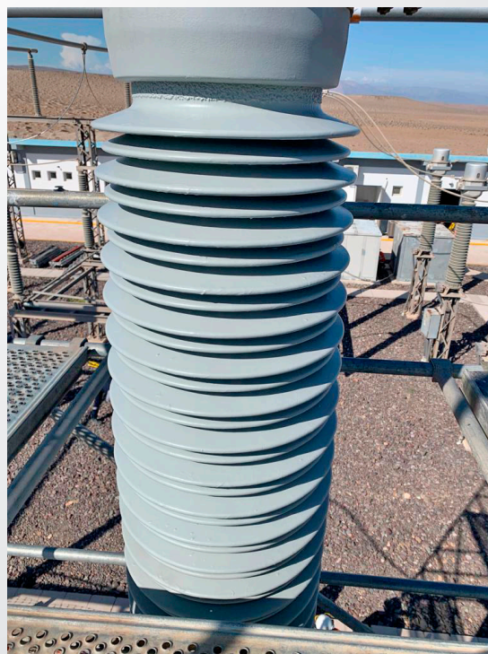
SECCIONADOR DE POTENCIA SILICONADO.
