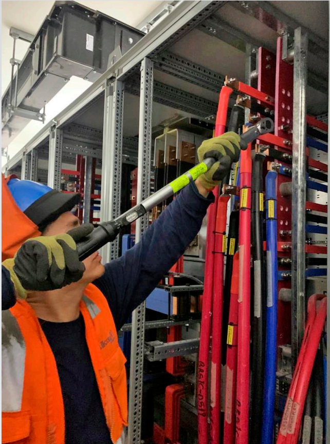
VERIFICACIÓN DE TORQUE DE PERNERÍA DE CONTACTO EN LLEGADA Y SALIDA DE CABLES
