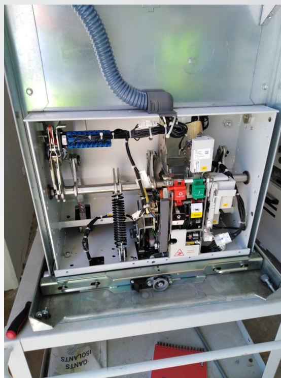
INSPECCIÓN Y LUBRICACIÓN DE MECANISMO INTERNOS
