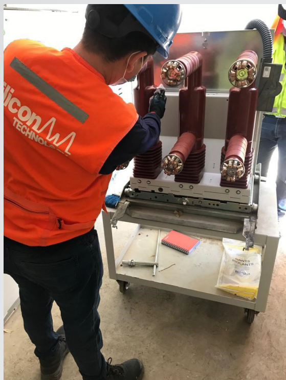
INSPECCIÓN Y APLICACIÓN DE GRASA CONDUCTIVA A CONTACTOS PRIMARIOS
