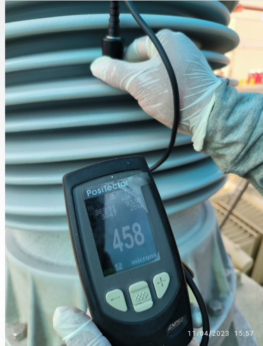
MEDICIÓN DE ESPESOR DE RECUBRIMIENTO EN BUSHINGS DE TRANSFORMADOR.
