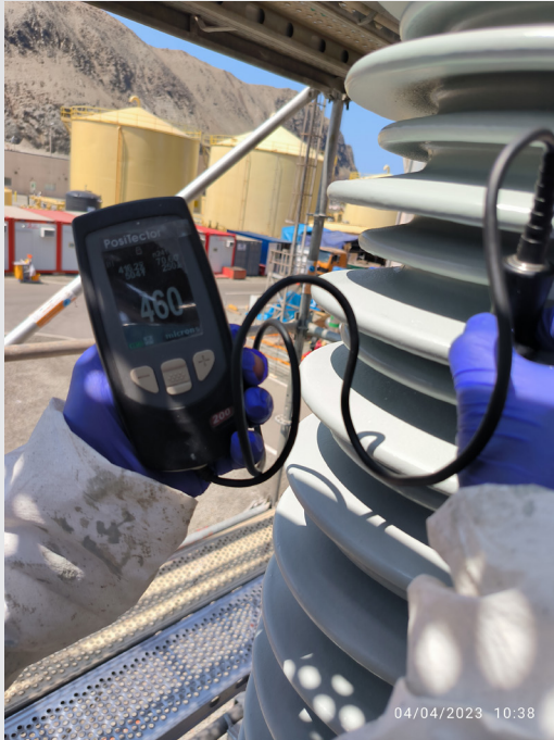
MEDICIÓN DE ESPESOR DE RECUBRIMIENTO EN PARARRAYOS.
