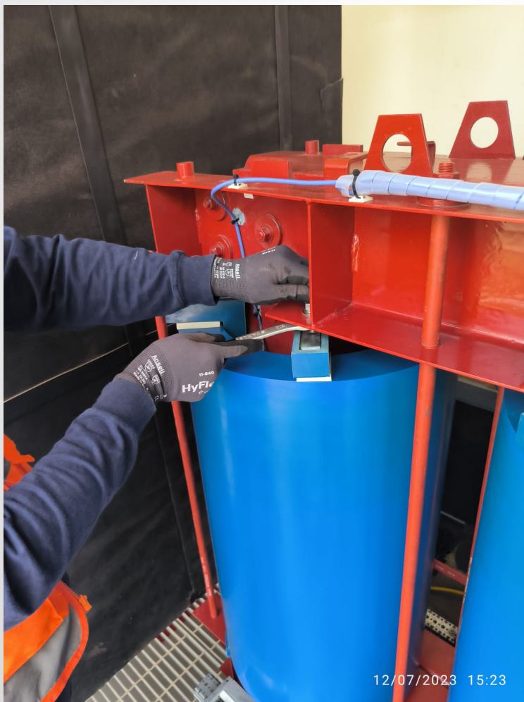
CONEXIONADO Y AJUŞTE DE PERNERÍA DE FIJACIÓN DE SOPORTES ANTI VIBRATORIOS
