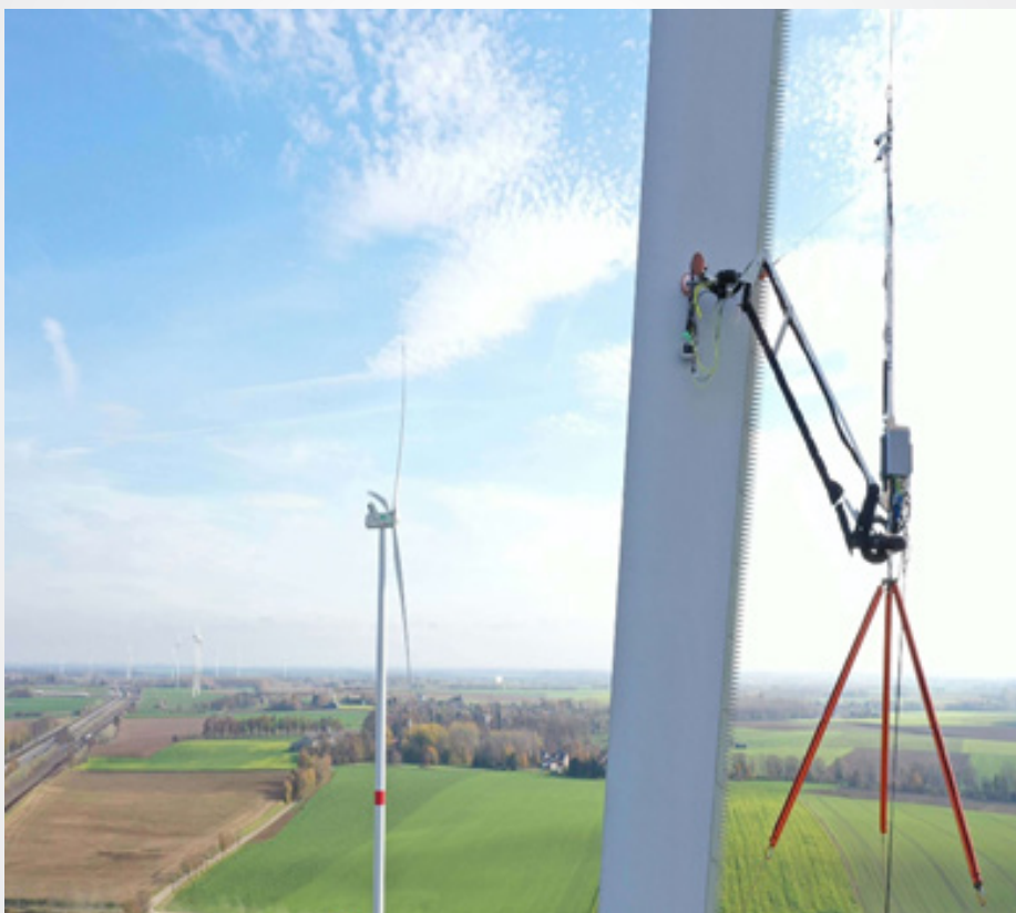
Robot inspecciona y repara turbinas eólicas
