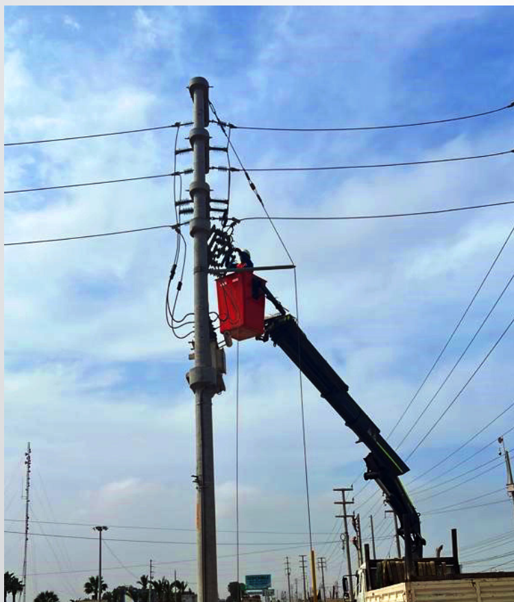
RETIRO DE SECCIONADORES – POSTE PMI
