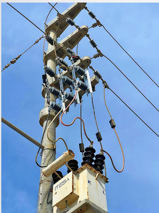
INSTALACIÓN DE SECCIONADORES – POSTE PMI
