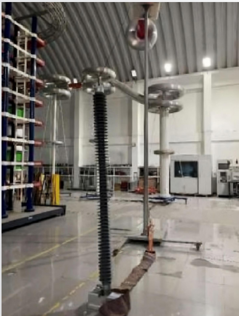
ENSAYO DE TENSIÓN APLICADA A FRECUENCIA INDUSTRIAL EN SECO.
